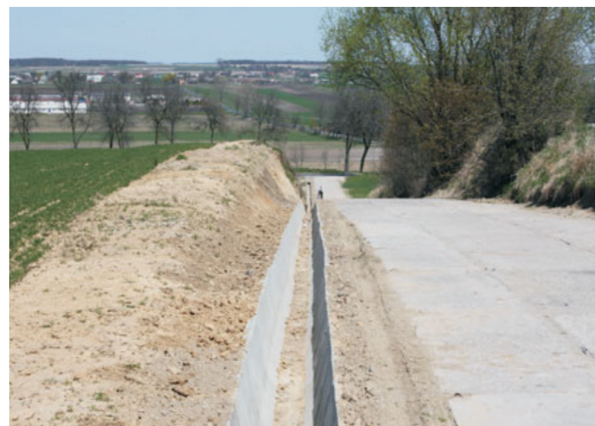
Zabezpieczenia przed erozją (fot. J. Bański) Safeguards against erosion (by J. Bański)
