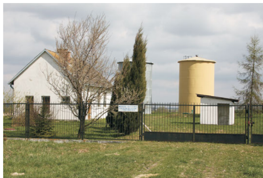
Stacja wodociągowa na wsi (fot. J. Bański) Water supply system station (by J. Bański)
