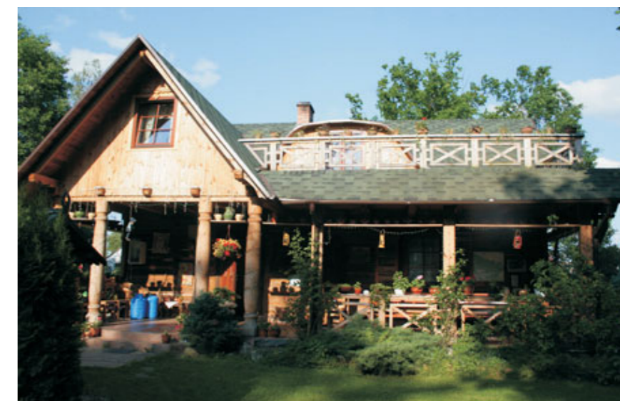
Kwaterna agroturystyczna wykorzystująca tradycyjne budownictwo regionalne (fot. M. Bednarek-Szczepeńska) Agritourism lodging in a traditional regional style (by M. Bednarek-Szczepeńska)
