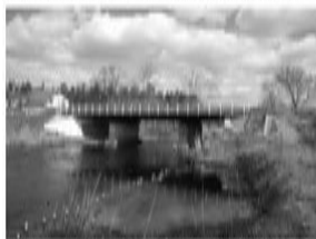
Fot. 3. Most drogowy nad Drwęcą Pic. 3. The road bridge over Drwęca
