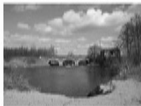
Fot. 4. Żabytkowy most kolejowy Pic. 4. Historic rail bridge
