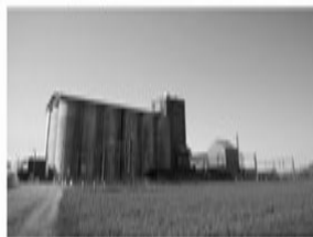
Fot. 2. Elewator zbożowy - dominanta Pic. 2. The grain elevator - dominant
