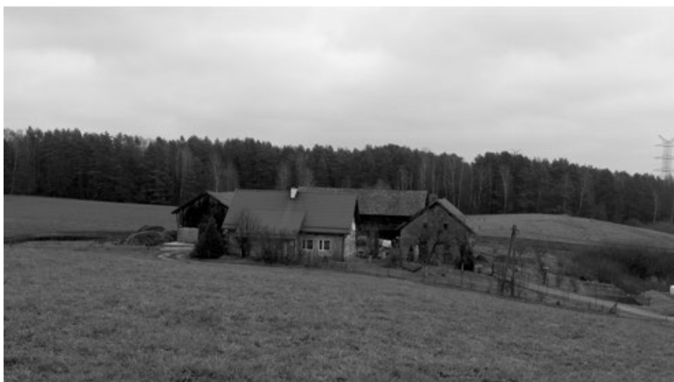
Fot. 2. Nieznacznie przekształcona zabudowa o układzie zagrodowym (fot. P. Pawelec, listopad 2015) A slightly converted building structure with a farmstead layout (photo: P. Pawelec, November 2015)
