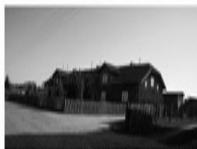
Fot. 8. Żabytkowy budynek mieszkalny Pic. 8. Historic residential building
