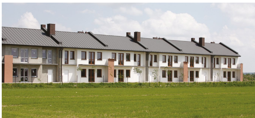
Nowe osiedle mieszkaniowe budowane w Łosicach (województwo mazowieckie) New housing estate built in Łosice (Mazowieckie voivodship)
