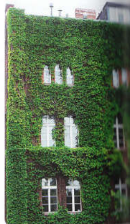
Wyjątkowym pomnikiem przyrody jest winobluszcz trójklapowy, który obrasta ścianę jednego z budynków w Bydgoszczy.
